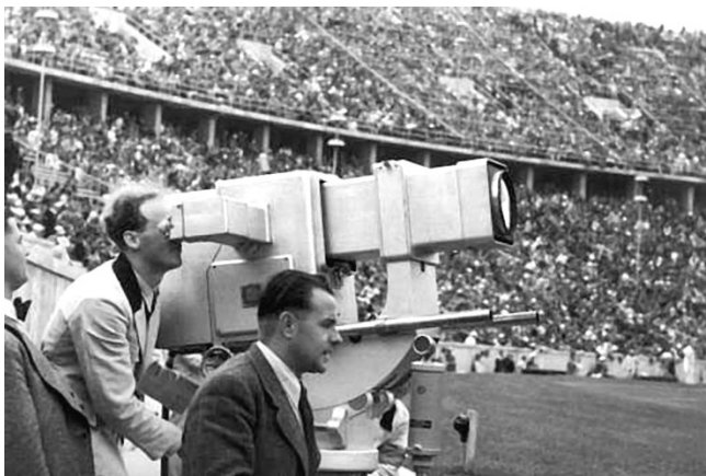
Fig. 1-6 Telefunken Iconoscope camera, 1936, Wikimedia commons
